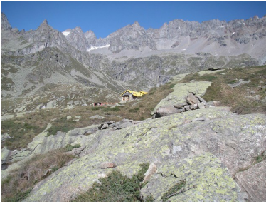
Il rifugio visto da sud
