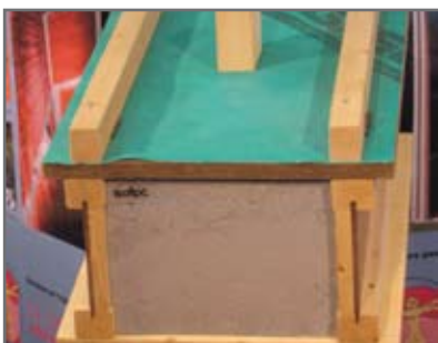
Esempio di isolamento termico di tetto in legno esistente mediante fibra di cellulosa e pannelli in fibra di legno. www.lacasaditerra.com
